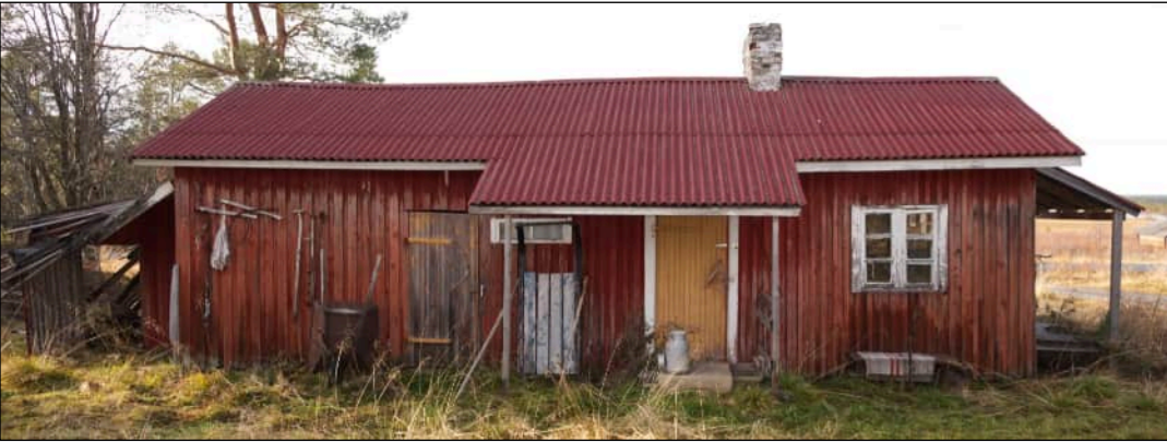
Fig. 070: Julkisivu itään FI-kuvat, 2024
