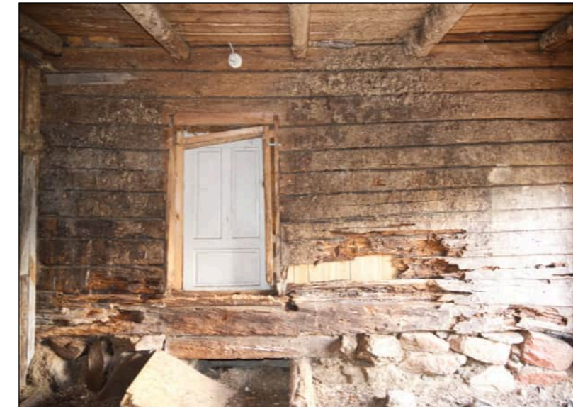
Fig. 098: Valehirsi ja betonisokkeli FI-kuvat, 2024
