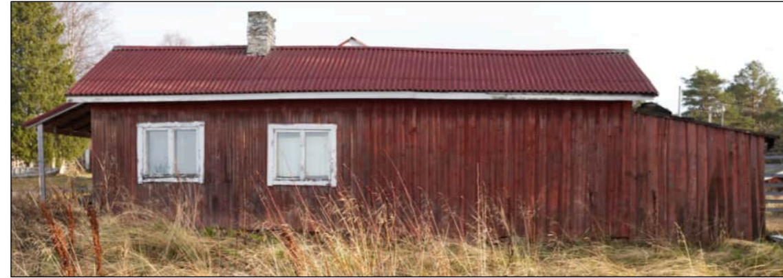
↑ Fig. 071: Julkisivu länteen FI-kuvat, 2024
