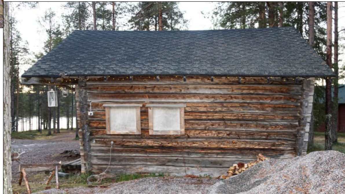
Fig. 183: Julkisivu itään FI-kuvat, 2024
