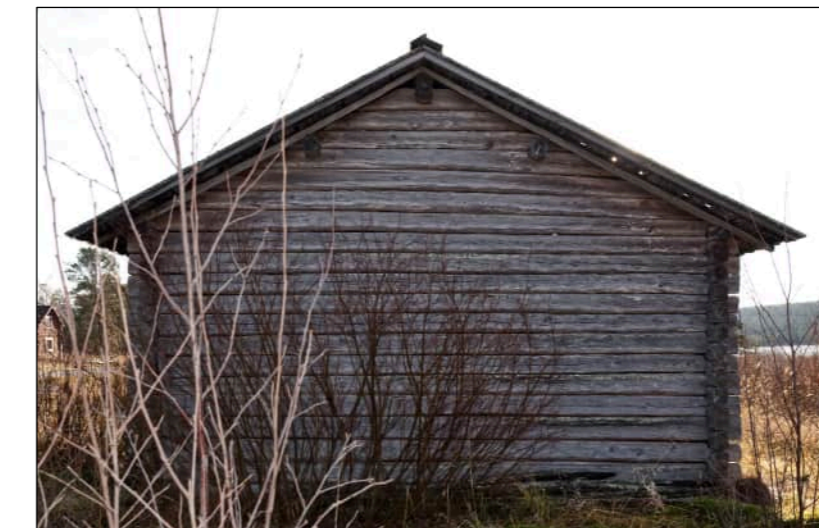
←← Fig. 050: Julkisivu itään FI-kuvat, 2024
