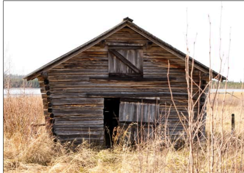
→ Fig. 041: Julkisivu itään FI-kuvat, 2024
