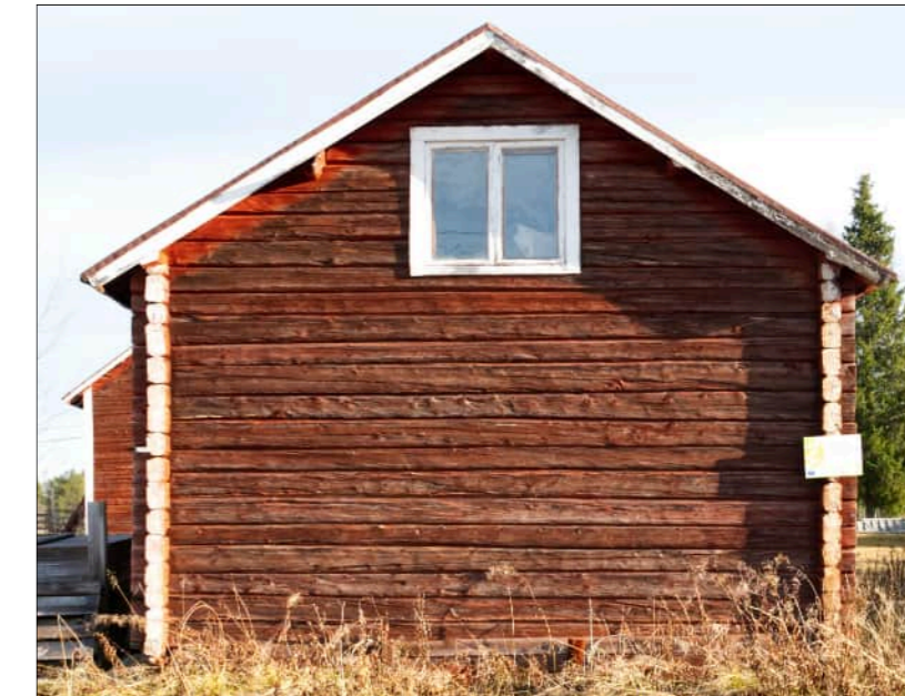
←← Fig. 064: Julkisivu itään FI-kuvat, 2024
