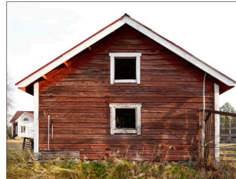
← Fig. 087: Julkisivu länteen FI-kuvat, 2024
