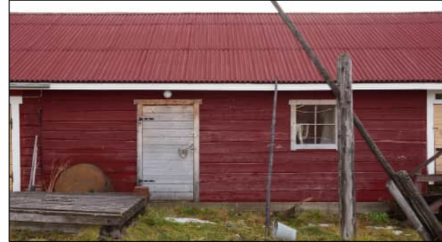
Fig. 082: Julkisivu pohjoiseen Moderni keskiosa / valehirsi / rankaseinä Anakrooninen betonisokkeli FI-kuvat, 2024
