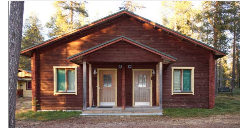
←← Fig. 175: Julkisivu itään FI-kuvat, 2024
