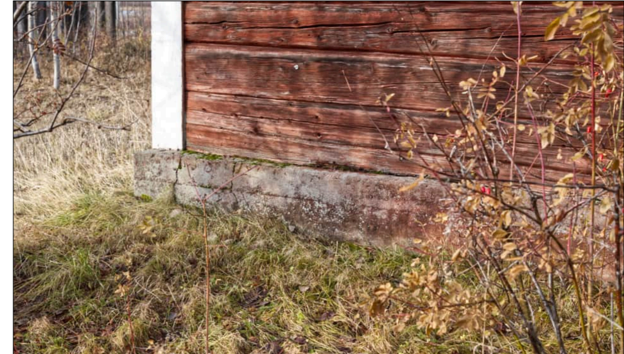
↓ Fig. 116: Kohtalokas betonisoskeliratkaisu alahirrelle, joka on laho. Onneton korjaus (lisäys), vesilistan poisto vai taidon puute? FI-kuvat, 2024
