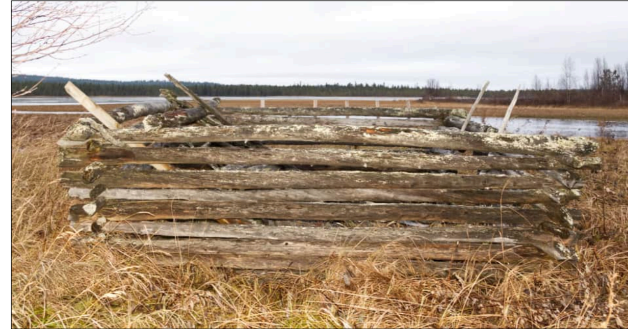
Fig. 033: Julkisivu itään FI-kuvat, 2024
