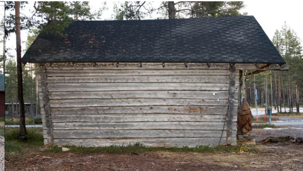
Fig. 184: Julkisivu länteen FI-kuvat, 2024
