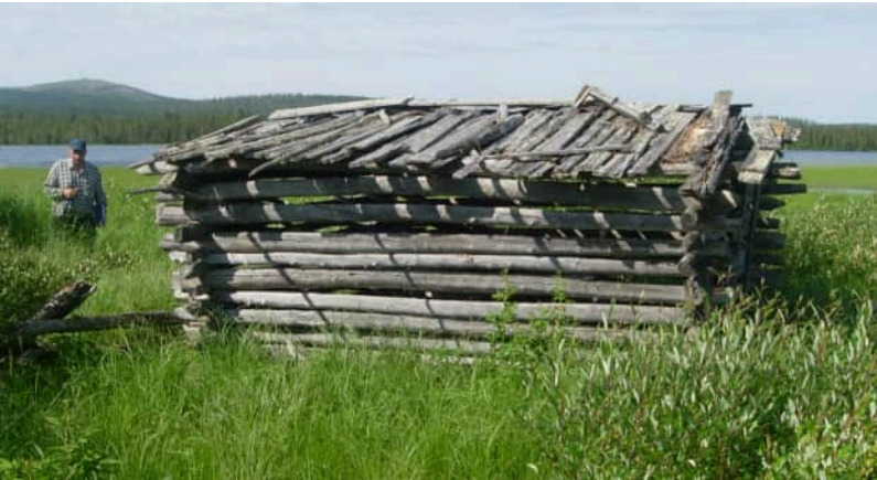
↑ Fig. 036: ELY- keskuksen inventointi Jolloin katto oli yhä paikallaan LKYT-KUVAT
